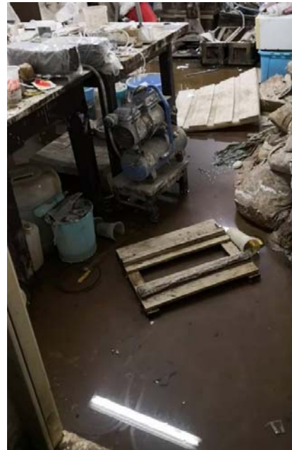
图 7 科学馆地下室
