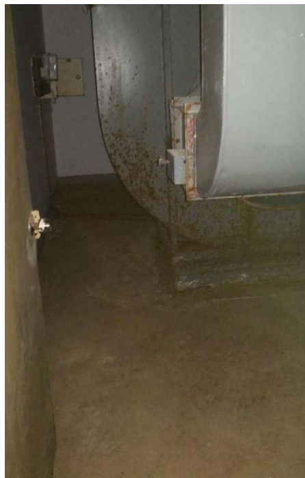
图 13 科学馆地下室
